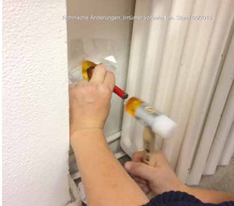
Stanzeisen durch den Beutel hindurch in den Putz treiben, ca. 5 -10 mm tief
