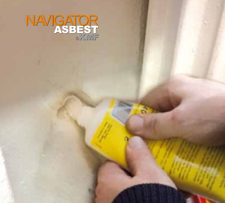
Die beschädigte Wandputzoberfläche mit einem Fertigspachtel verschließen
