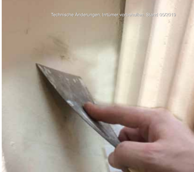
Fertigspachtel glätten und die Probenahmewerkzeuge gründlich mit Einweg- oder Staubbindetuch reinigen
